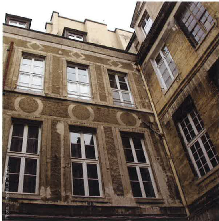
↓ Façade au plâtre, rue Geoffroy-l'Asnier (Paris) : enduits ornés datant de 1675.
