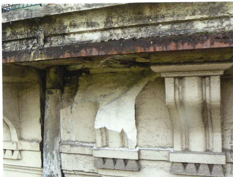
↑ Sels expansifs dus à une incompatibilité des matériaux.
