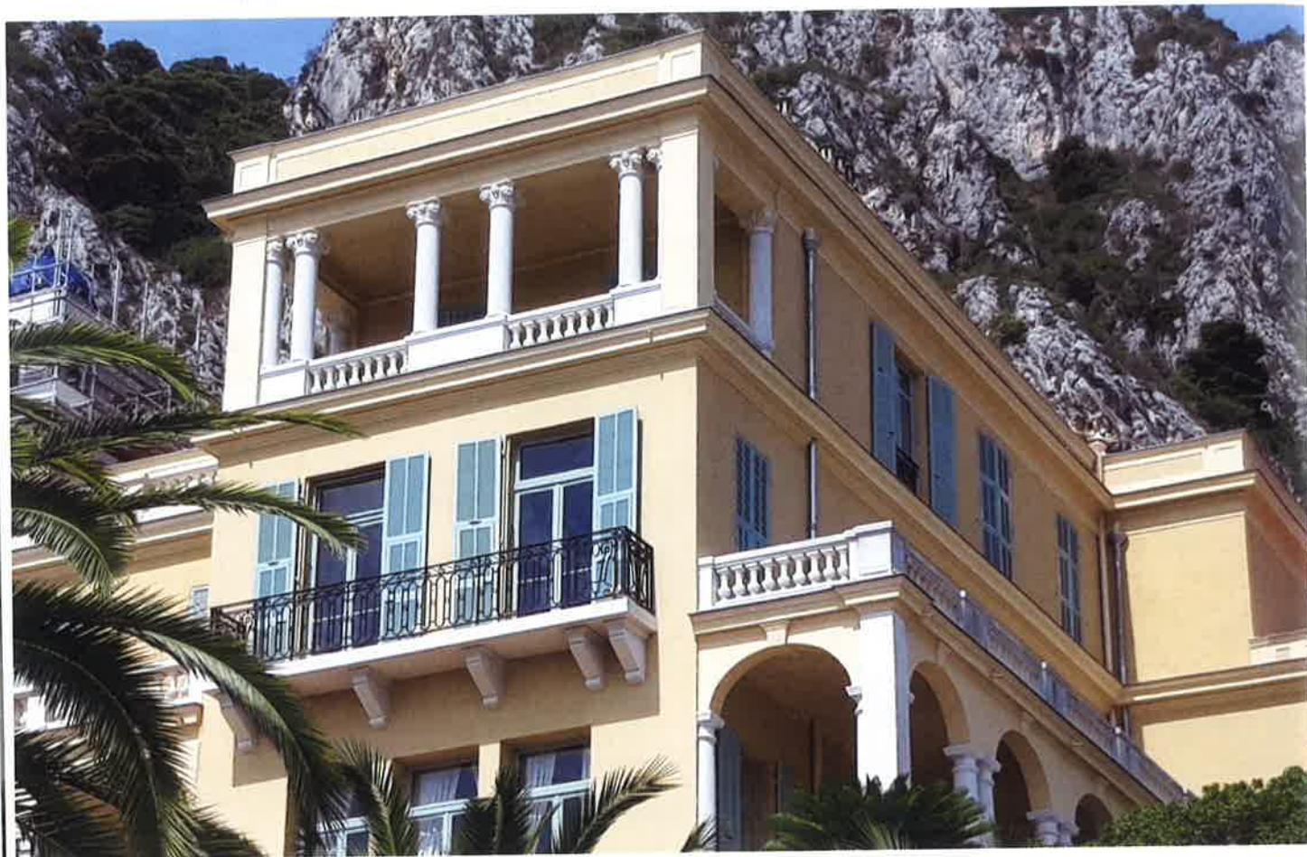
↑ Villa Maria-Serena (Menton) : corps d'enduit chaux-ciment pour assurer la durabilité face aux embruns.
