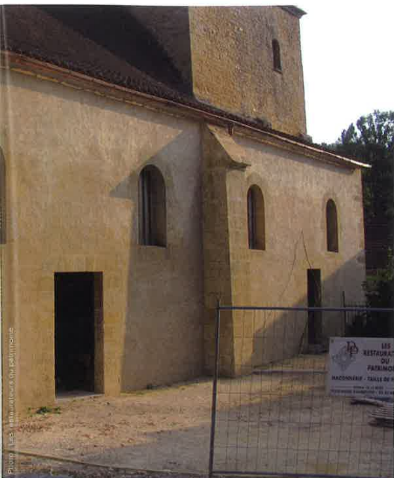
← Église de Journiac (Dordogne) : enduit au mortier de chaux lisse appliqué à la truelle.
