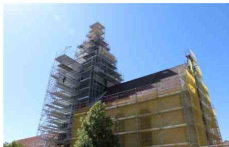
Les travaux de rénovation de l'église Saint-Nicolas d'Oberentzen ont débuté. Photo L'Alsace/Christian WERTHE
