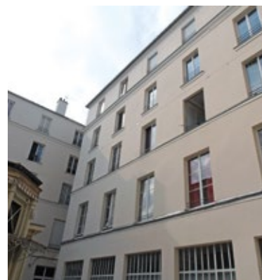
Chantier terminé - Façade rénovée en PARIS DÉCO®
