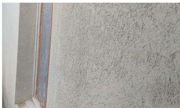
RPC prêt à recevoir la couche de finition.
