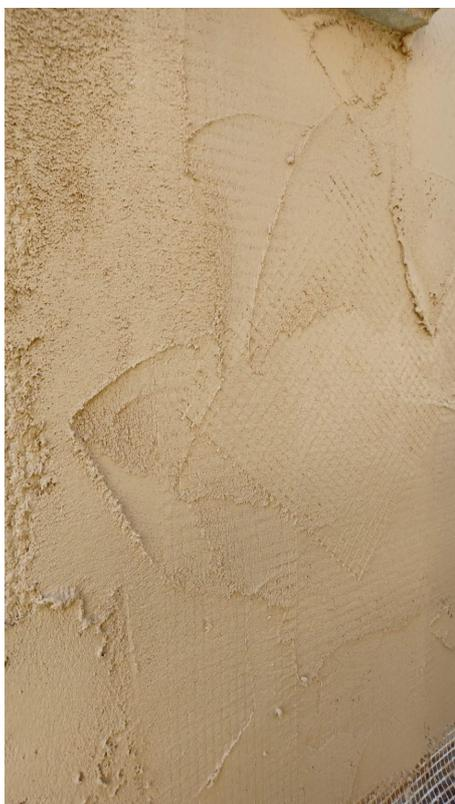
Une fois fini, l'enduit dispose d'une épaisseur comprise entre 15 et 20 mm maximum. Quant à l'aspect final, *Kalamua™* peut être gratté ou gratté puis taloché à l'éponge pour ne pas refermer le support et lui permettre de respirer.
