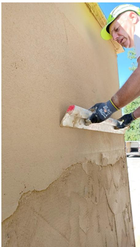
*Kalamua™* s'applique soit à l'aide d'un sablon ou d'une machine à projeter et peut également être employé à l'intérieur du bâti. Ce mortier est composé de chaux hydraulique du chauffournier, de charges minérales et de pigments minéraux 100 % naturels ainsi que d'adjuvants facilitant sa mise en œuvre. *Kalamua™* complète sa gamme biosourcée.
