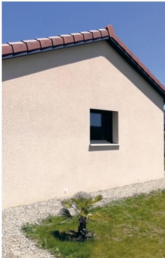
Rendu de la SOUS-COUCHE sur garage, et en attente de recevoir l'enduit de finition.
