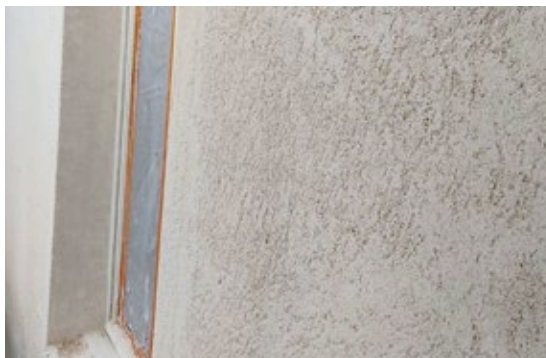
RPC® prêt à recevoir la couche de finition.
