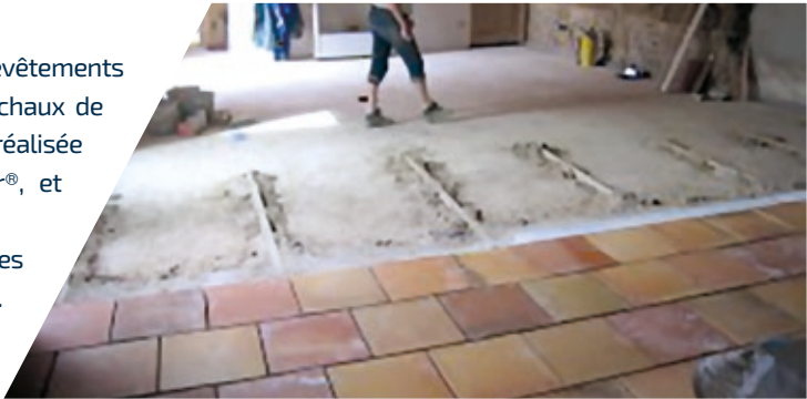
Pose de terre cuite
