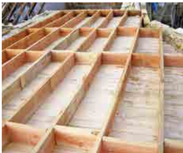
Vue d'un coffrage avant remplissage.
