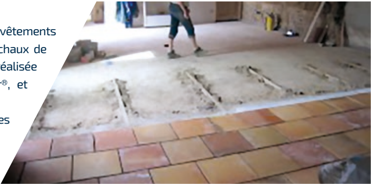
Pose de terre cuite
