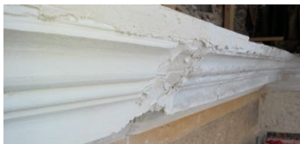
Restauration des bandeaux de façade – Domaine de Dampierre en Yvelines (78)
