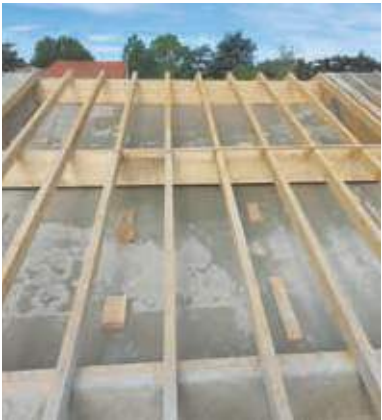
Vue du coffrage sur toiture avant remplissage.
