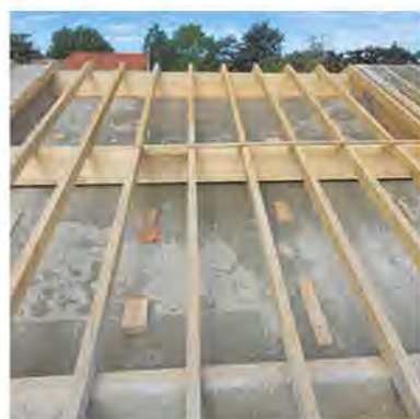
Vue du coffrage sur toiture avant remplissage.
