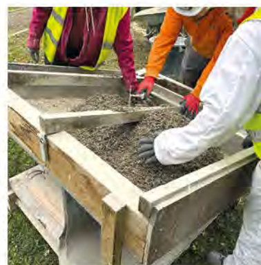
Isolation béton de chanvre en toiture
