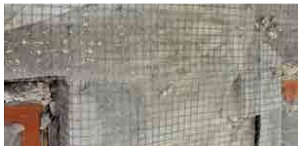
Préparation : mise en place du treillis soudé galvanisé avant mise en œuvre du mortier
