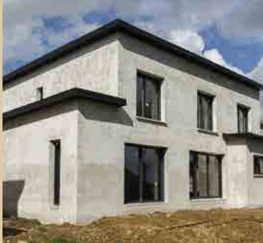
Maison de particulier (49)- Sous-enduit ECOLIANT®
