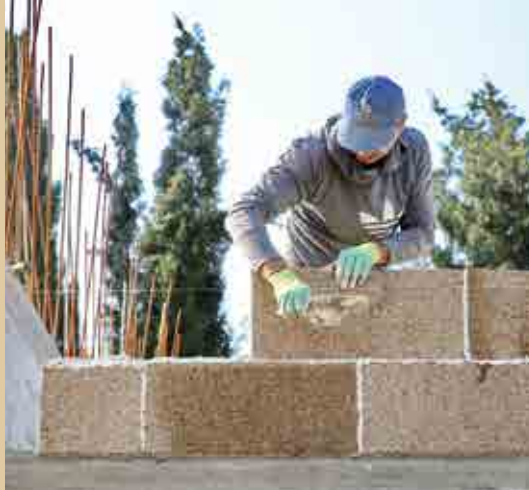
Montage de blocs de chanvre
