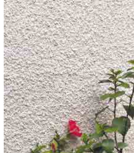
Rendu de l'enduit tyrolien
