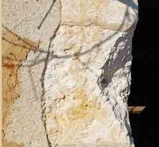
Avant réparation de pierre calcaire
