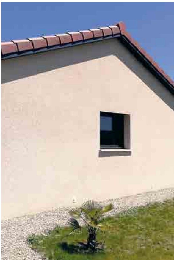
Rendu de la SOUS-COUCHE sur garage, et en attente de recevoir l'enduit de finition.
