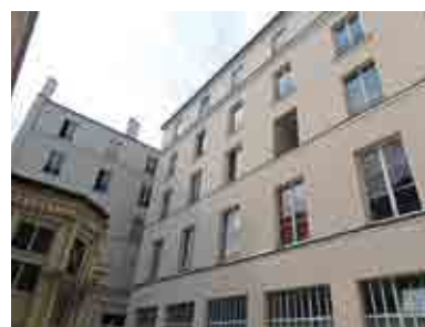
Chantier terminé - Façade rénover en PARIS DÉCO®
