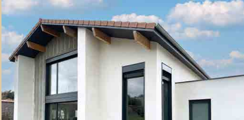
Maison de particulier - St Chamond (42)
