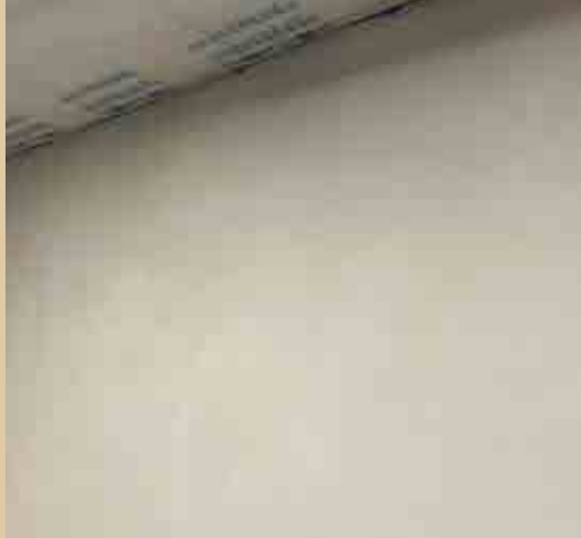
Enduit régulateur de fond
