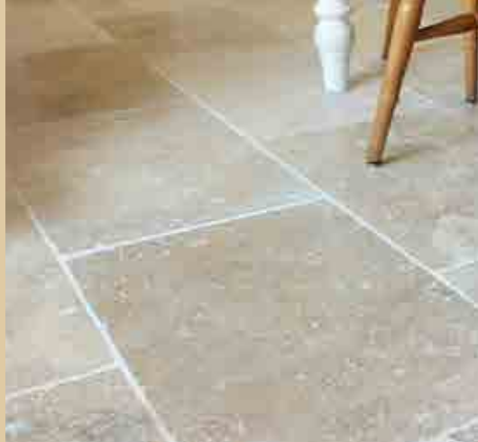
Joint blanc et dalle de travertin
