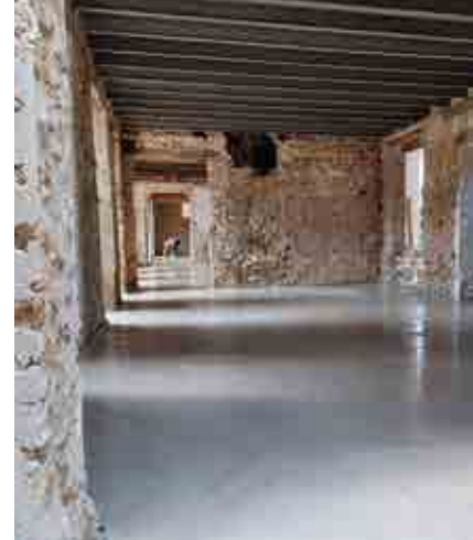
Coulage d'une chape de chaux
