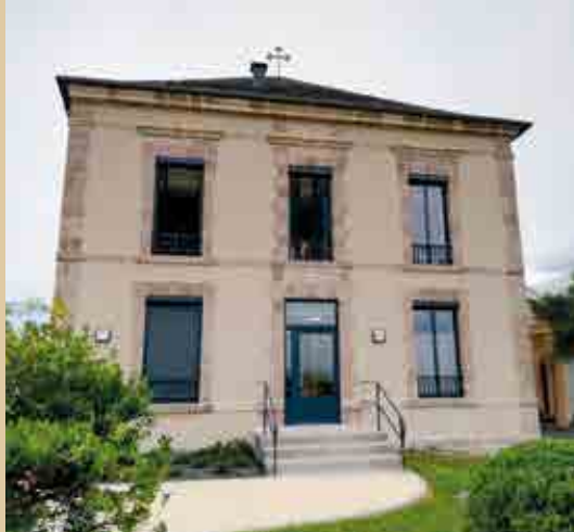
Façade Maison médicale (19)
