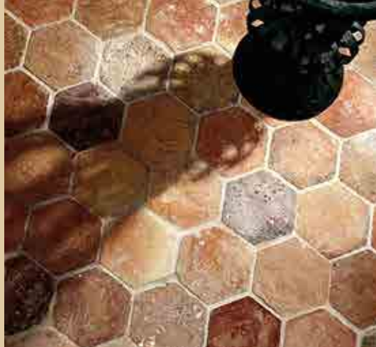
Sol en tomettes et joints à la chaux
