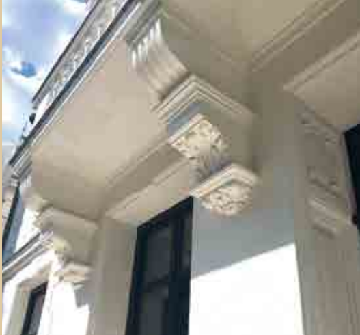
Éléments de façade Maison de particulier (Périgueux)
