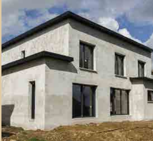
Maison de particulier (49)- Sous-enduit ECOLIANT®
