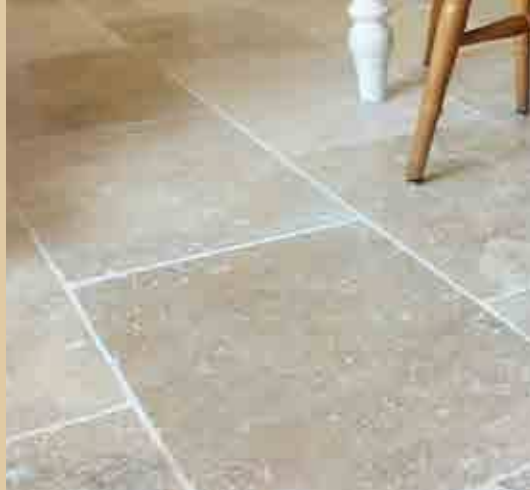
Joint blanc et dalle de travertin
