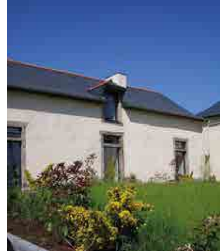
Enduit sur maison de particulier (22)
