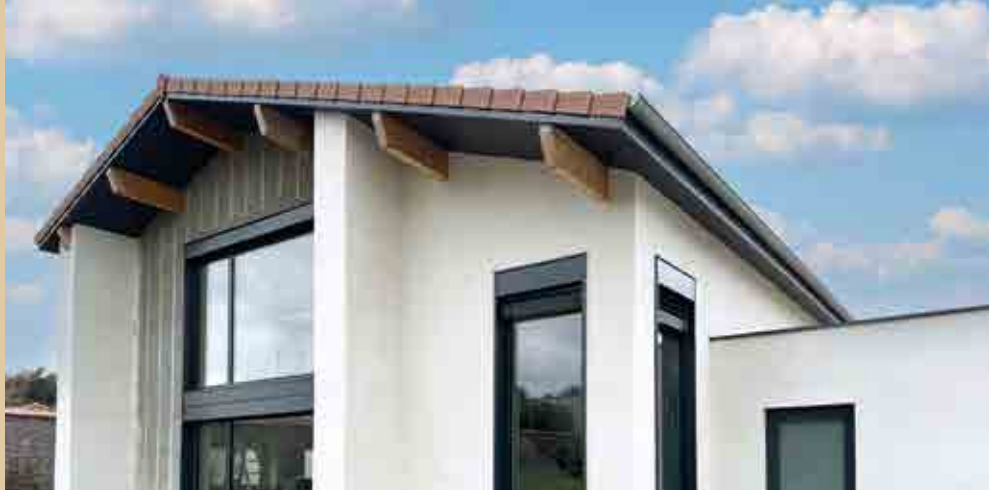
Maison de particulier - St Chamond (42)
