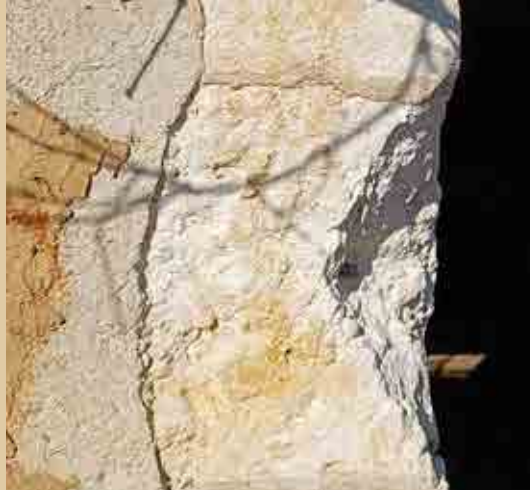
Avant réparation de pierre calcaire
