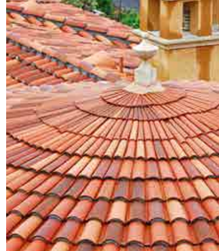
Scellement toit en tuiles
