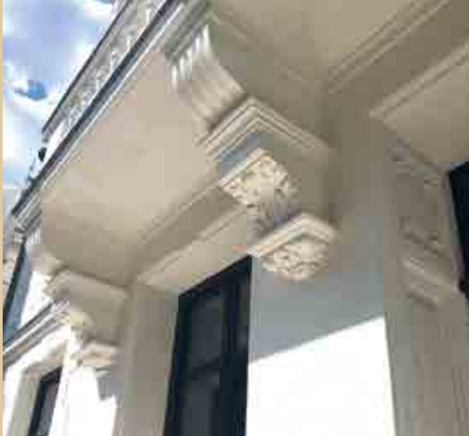
Éléments de façade Maison de particulier (Périgueux)
