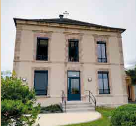
Façade Maison médicale (19)
