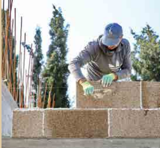
Montage de blocs de chanvre
