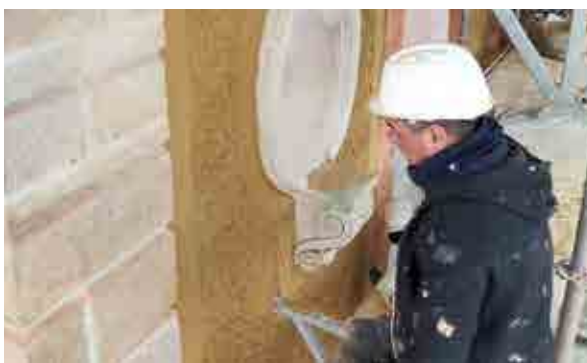
Réfection des enduits traditionnels Domaine de Dampierre (78) - Ets Pierre Noël
