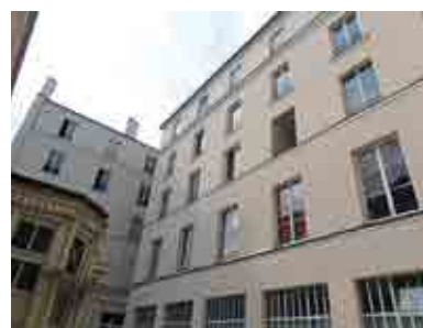
Chantier terminé - Façade rénoverée en PARIS DÉCO®
