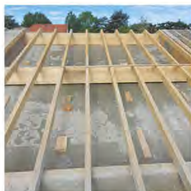
Vista del encofrado en techo antes del relleno.
