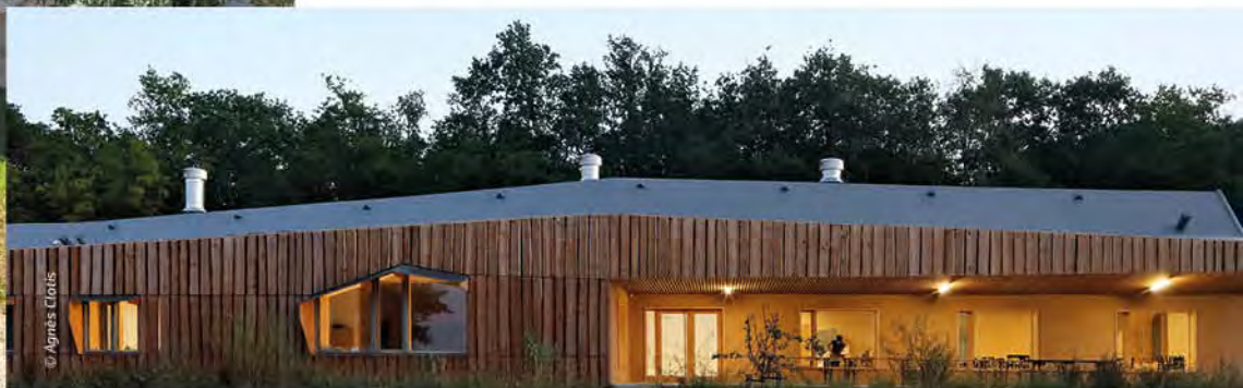
Albergue de Jóvenes Trabajadores / Siorac de Ribérac (24) Hormigón de cáñamo recubierto con un revoco TÉRECHAUX® NHL 2 y arena local Arquitectos: Dauphin Architecture
