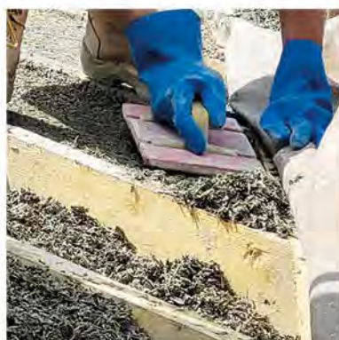
Relleno del techo.
